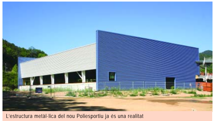
L'estructura metàl·lica del nou Poliesportiu ja és una realitat
